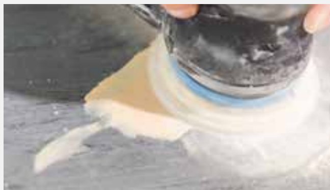
Ponçage après durcissement
