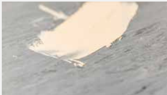
Appliquer une couche de FLOOR SEALER 72 Repair
