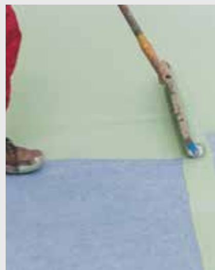
3 Appliquer le produit d'étanchéité à l'aide d'un rouleau en velours
