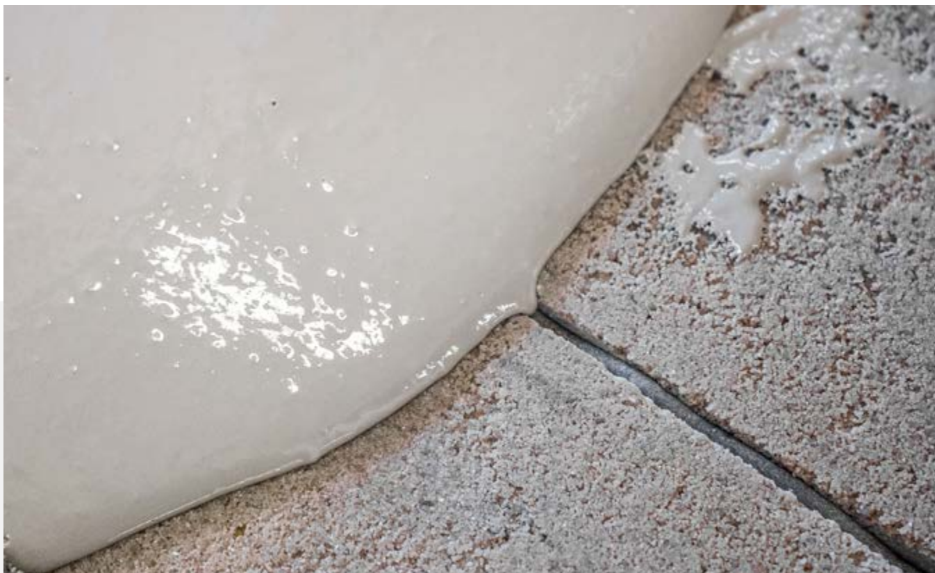
Des bonnes propriétés de lissage facilitent la mise en œuvre des matières de jointoiment.
