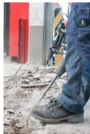
Burinage du béton.
