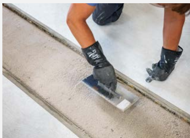
Reprofilage à l'épaisseur de couche souhaitée avec un mortier à durcissement rapide.
