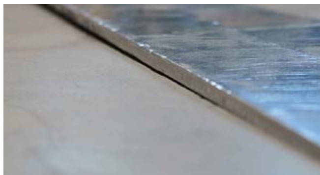
Avant : Profilé de joint en métal déformé.
