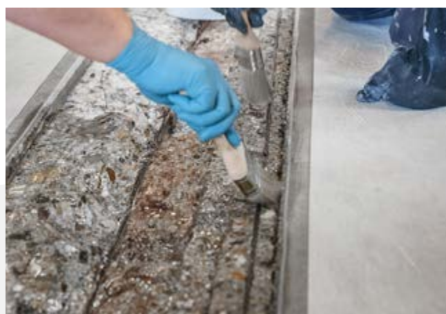
Application du primaire sur la zone du joint burinée.
