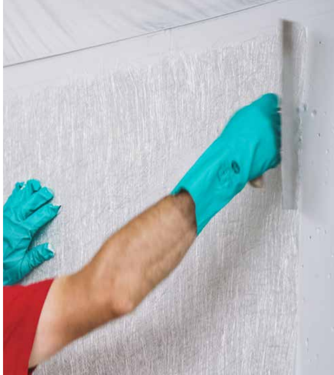
Einbettung des Armierungsvlieses in die EP 699 S Grundschrift.
