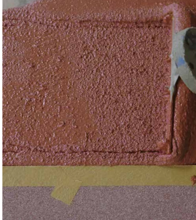
Präziser Einbau mit Stiftraket für maßgeschneiderte Oberflächen.
