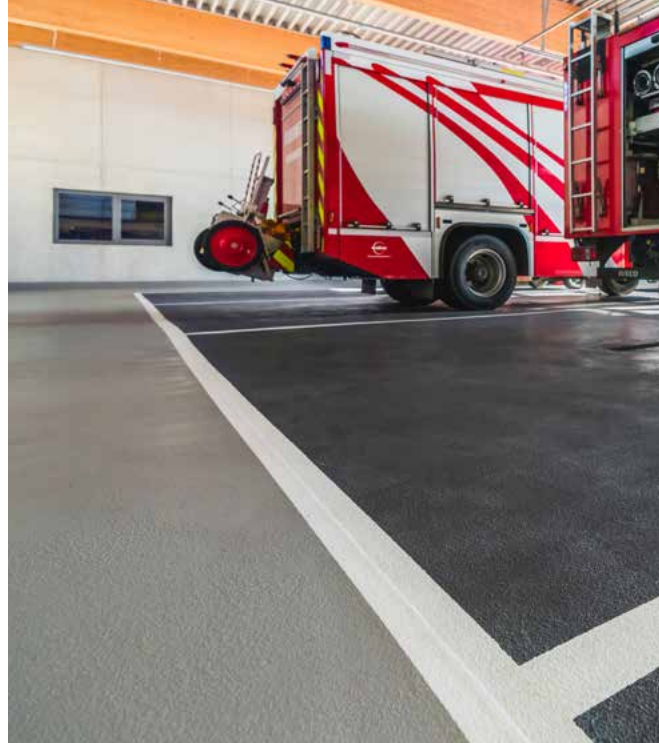
Flexibles OS 8-System als optimale Lösung für rissgefährdete Untergründe.
