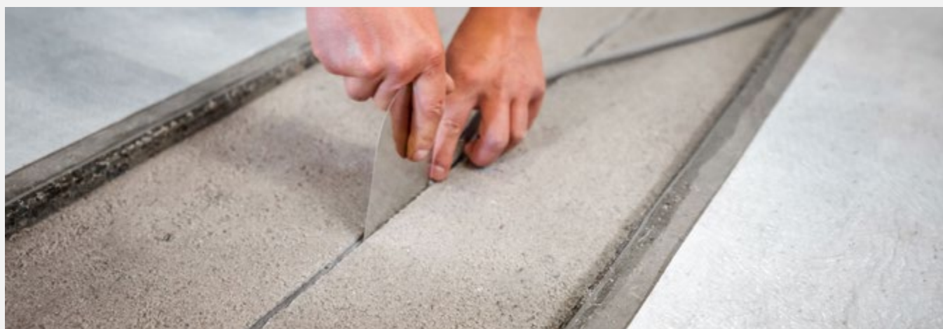
Einlegen des KLB-PE Rundprofils in den Trennschnitt.
