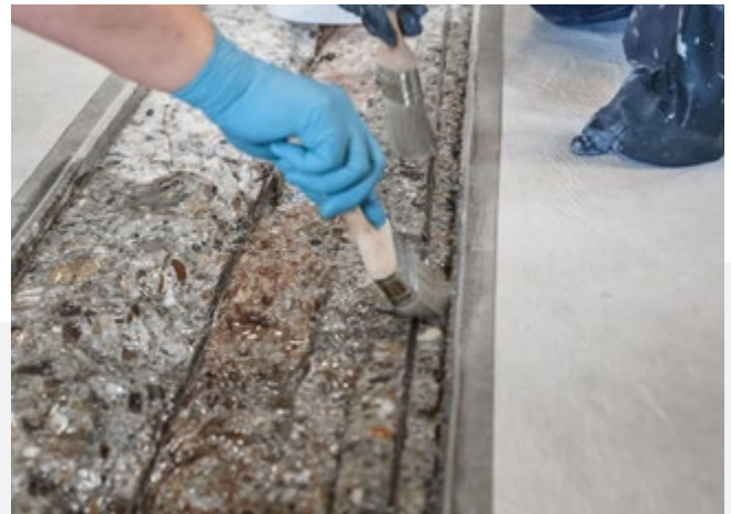
Grundierung des ausgestemmt Fugenbereiches.
