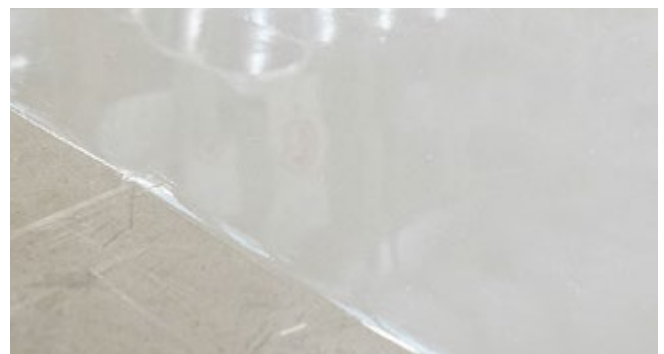
Nachher: Planebene Ausführung mit KLB-Fugenvergussmasse.
