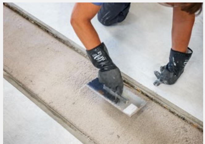
Reprofilierung auf die Sollschichtdicke mit einem schnellhärtenden Mörtel.
