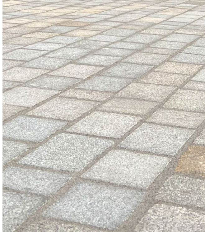
Drainagefähiger Fugenmörtel verhindert einen Unkrautbewuchs.
