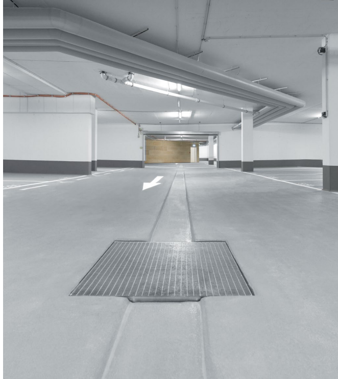
Flexibles OS 11a-System als optimale Lösung für rissegefährdete Untergründe.
