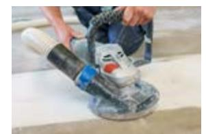
**Optional bei erhöhtem optischen Anspruch:** Feinschliff mit Exzenterorschleifer, anschließend ab-saugen, Kratzspachtelung mit **PU 466** und nochmali- ger Feinschliff. Anschließende Versiegelung mit dem schnellhärtenden **PU 469**. Alternativ **PU 9018 Flex Color**.
