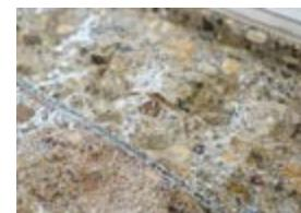
Bei Bedarf Ausbrüche mit einem Mörtel aus **PU 68 Rapid U** und **KLB-Mischsand 1** im Gew.-Verhältnis von 1 : 10 reprofiliieren. Nach Erhärtung des Mörtels (ca. 60 - 70 min) die verschlossene Fuge durch einen Trennschnitt wieder öffnen und mit einer geschlossen-zelligen PE-Rundschnur geeigneter Breite versehen. **Die Fugengeometrie ist zwingend den baulichen Bedingungen anzupassen!** Ggf. Beratung einholen.
