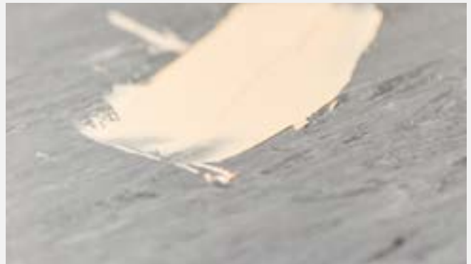
Verspachtelung mit FLOOR SEALER 72 Repair
