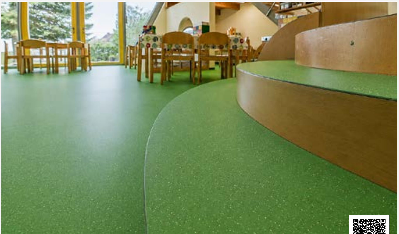
Nachher: Fugenlose, farbige PU-Versiegelung mit dekorativer Chipseinstreuung
