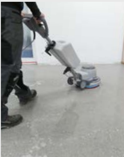
1 Reinigung der zu beschichtenden Flächen
