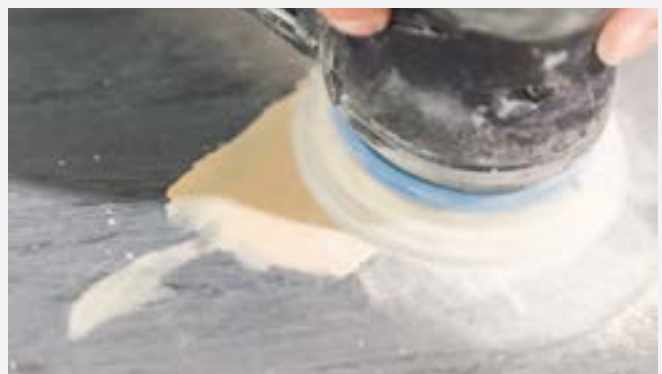
Plan schleifen nach Erhärtung
