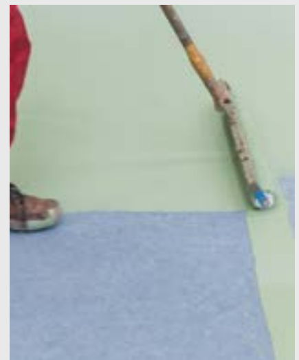
3 Versiegelung auftragen durch Aufwalzen mit der Veloursrolle
